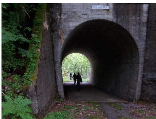
写真1 廃道のトンネル(1人では怖くて来れない)
